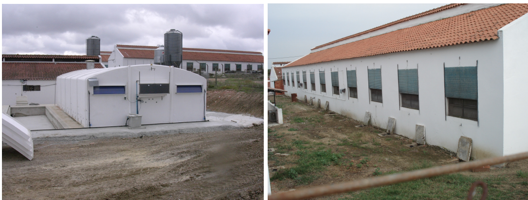
Figura 3-Aspecto do exterior do pavilhão de recria e de um pavilhão de engorda.
